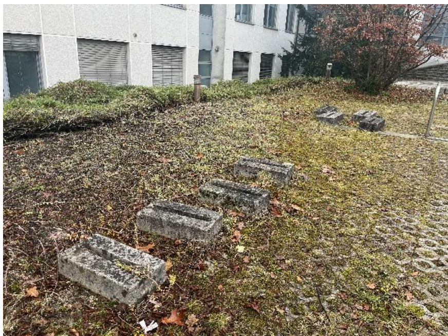
Slika 26: dotrajana betonska stojala pred vhodom oddelka za mikrobiologijo BF UL
