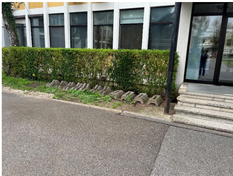
Slika 116: dotrajana betonska stojala za kolesa pred vhodom VF UL (enota na Gerbičevi ulici)
