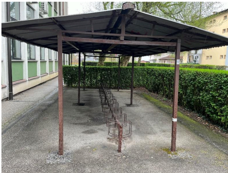
Slika 115: dotrajana pokrita stojala za kolesa ob stavbi VF UL (enota na Gerbičevi ulici)
