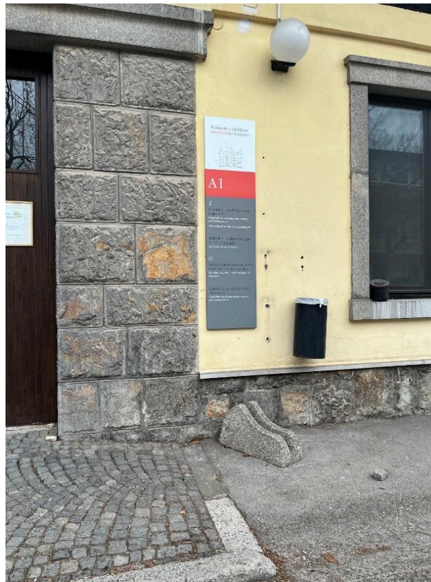
Slika 119: naključno postavljeno betonsko stojalo na VF UL
