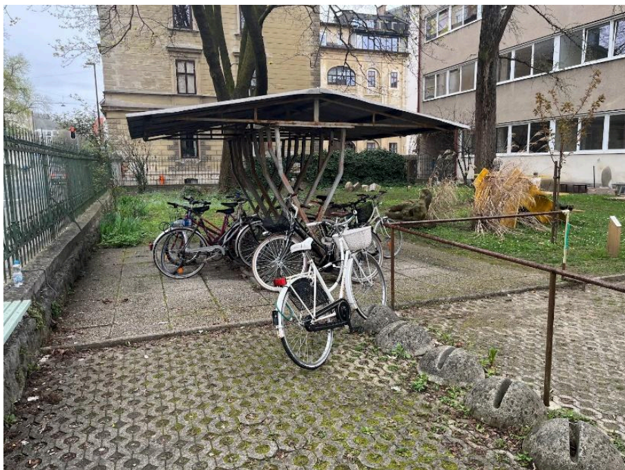
Slika 11: dotrajana kolesarnica ob ALUO UL (enota na Erjavčevi cesti)
