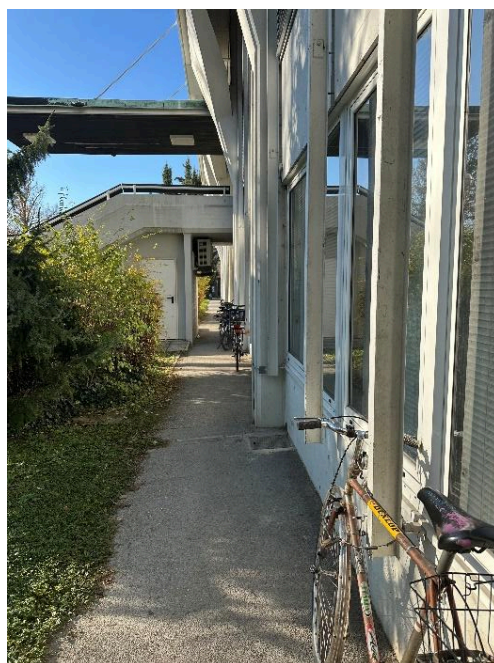
Slika 55: zaklepanje koles ob stavbo FGG UL
